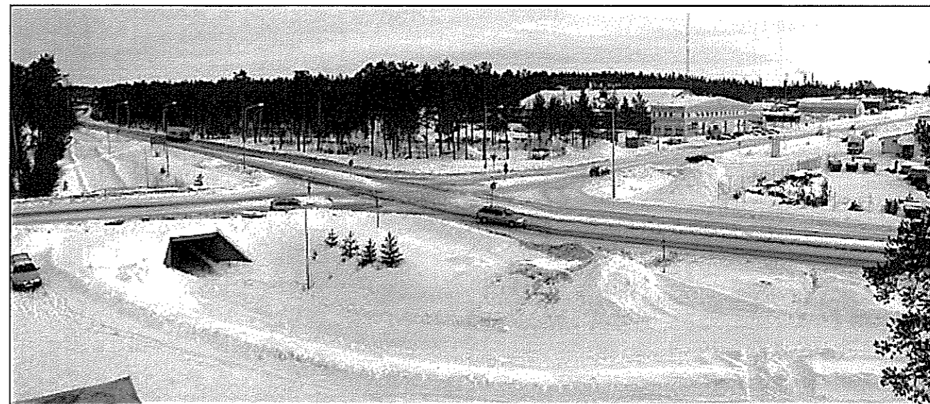
Bild 4.6-2: Korsning Centrumvägen/väg 721 (Järnvägsgatan)/väg 715 (Vitvattenvägen). Olycksdrabbad korsning, se karta 4.6-1.
