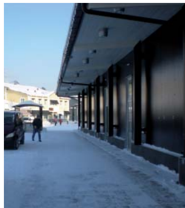
Figur 72. Ett utskjutande skärmtak utmed gallerian skyddar till viss del mot obehagliga väderförhållanden.
