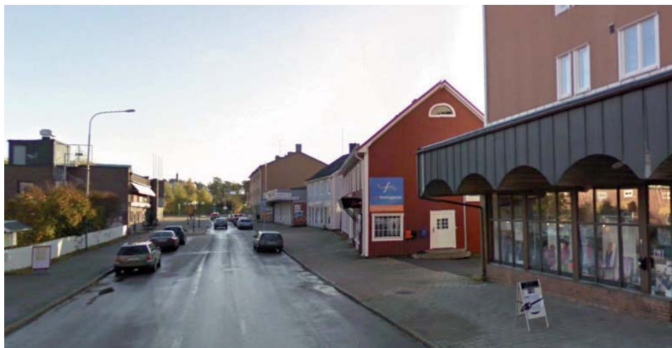
Figur 83. Byggnadernas placering i vinkel mot varandra skapar intressanta rumsbildningar längs stråket. Källa: Google maps
