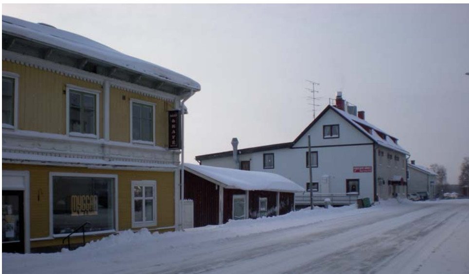
Figur 88. Bebyggelsens standard längs Köpmannagatan är av starkt varierad karaktär. Vissa uthus och förrådsbyggnader, likt den på bilden ovan, är näst intill fallfärdiga.
