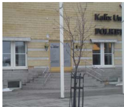
Figur 85. Vid en av gavlarna till Folkets Hus finns en trappa som kan nyttjas som sekundär sittplats. Trappan är dessutom i söderläge.
