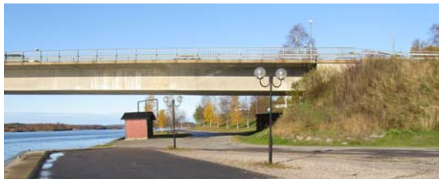
Bilvägen till strandängarna under Kalixbrons norra landfäste
