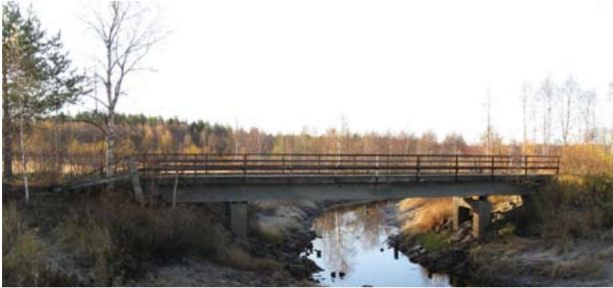
Betongbalkbro vid gamla Kustlandsvägen öster om Månsbyn
