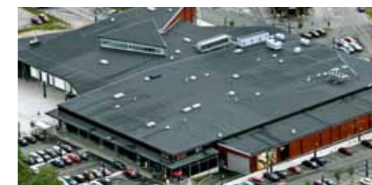
Kv. Slaktaren med Galleria Kalix
