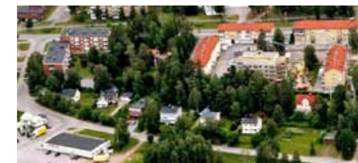
Västra delen av Kv Manhem
