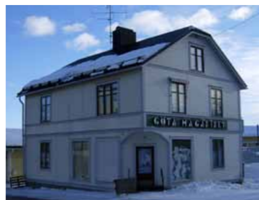
Bevarandevärd byggnad på Handeln 16
