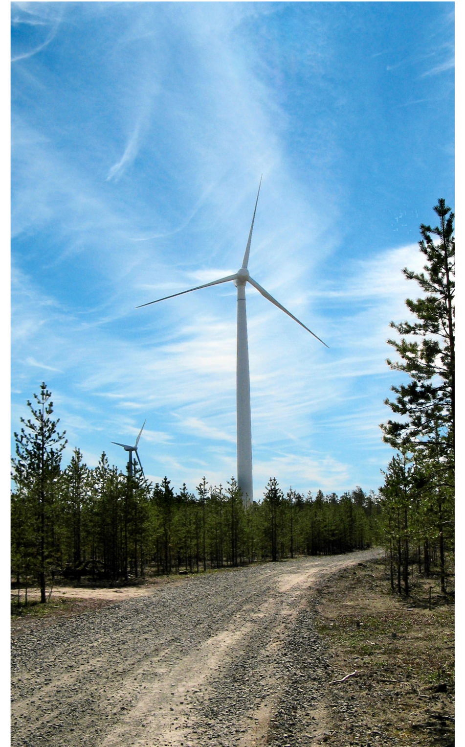
Figur 2.1:2 Vindkraftverk på Seskarö.
