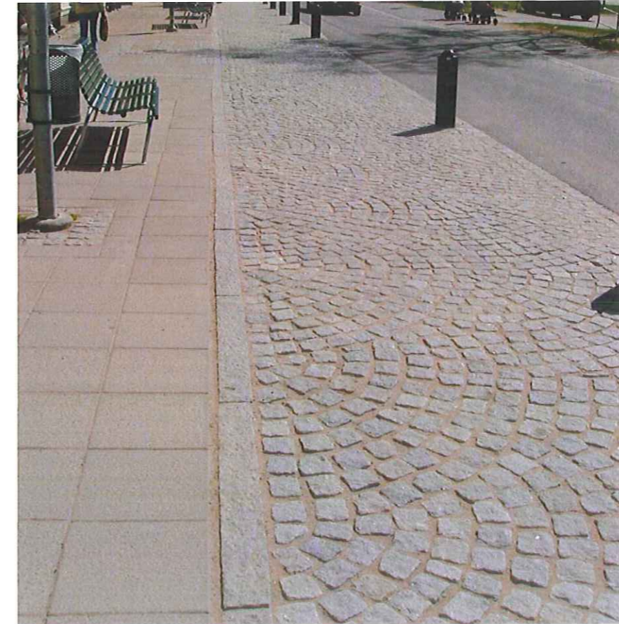
Befintlig markbeläggning som bibehålls.
