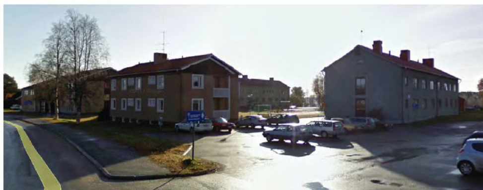
Foto på befintliga byggnader inom planområdet längst Norrbyvägen. Östergård syns längst till vänster i bild, sedan Mellangård och längst till höger visas Norrgård. I bakgrunden syns Södergård (Källa: Google Earth 2017-08-29)
