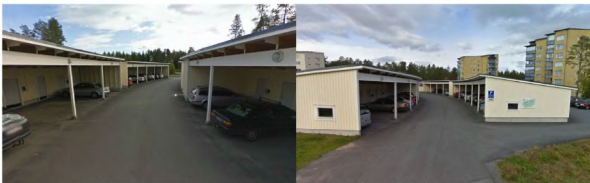
Figur 17. Carportar byggda i en böjd form med tillhörande förråd på stadsdelen Kronan i Luleå. (Vyer från Google Earth 2013)
