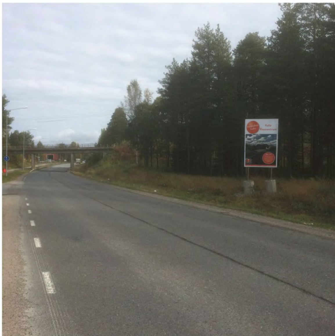
Järnvägsviadukten över Vitvattenvägen (allmän väg nr 715). Området till höger.
