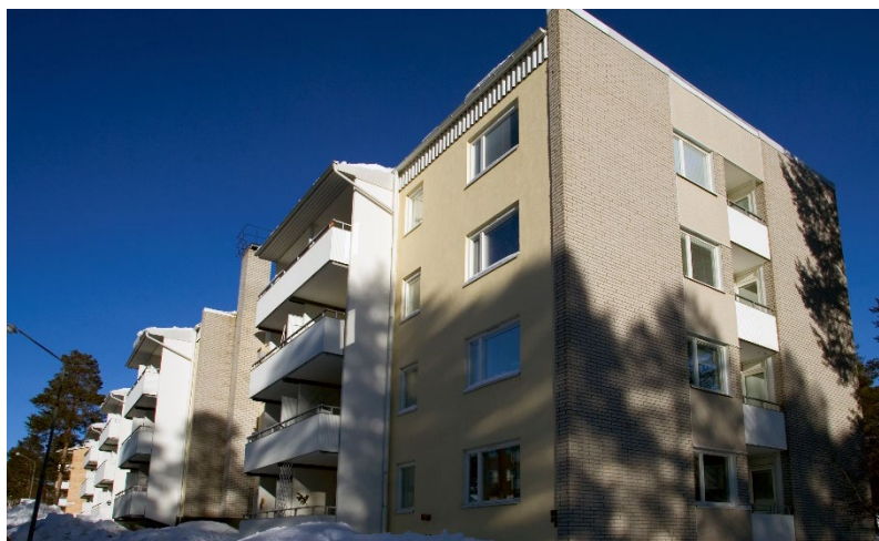
Foto. Flerfamiljsbostäder vid Rammelbergsvägen, Duvan 3 (Stiftelsen Kalixbo).
