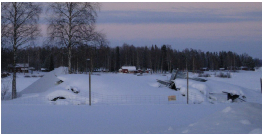
Bild 1 Foto från den 2 februari 2018 över rivningsavfallet som stängslogs in.
